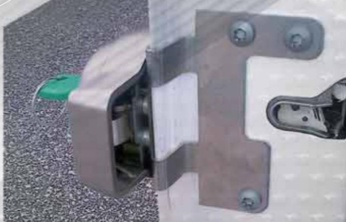
Serratura con cilindro di sicurezza antitrapano,
